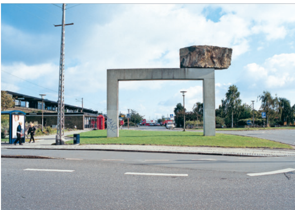
Frihedens port, 1981, Friheden Station, Hvidovre (i samarbejde med Stig Brøgger og Mogens Møller)
