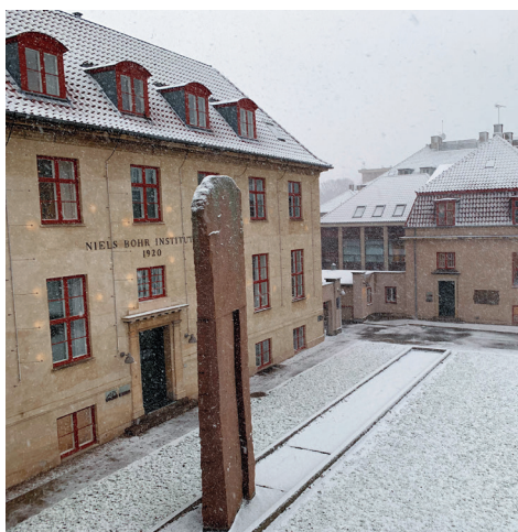
Niels Bohr Institutets facade ud mod Blegdamsvej
