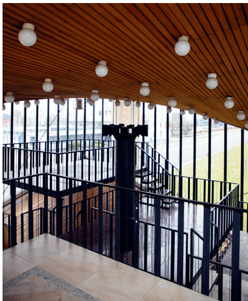
Udstillingsbygning til Egetæpper, Herning 1959
