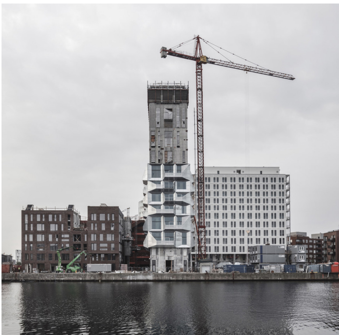
COBEs The Silo under opbygning
